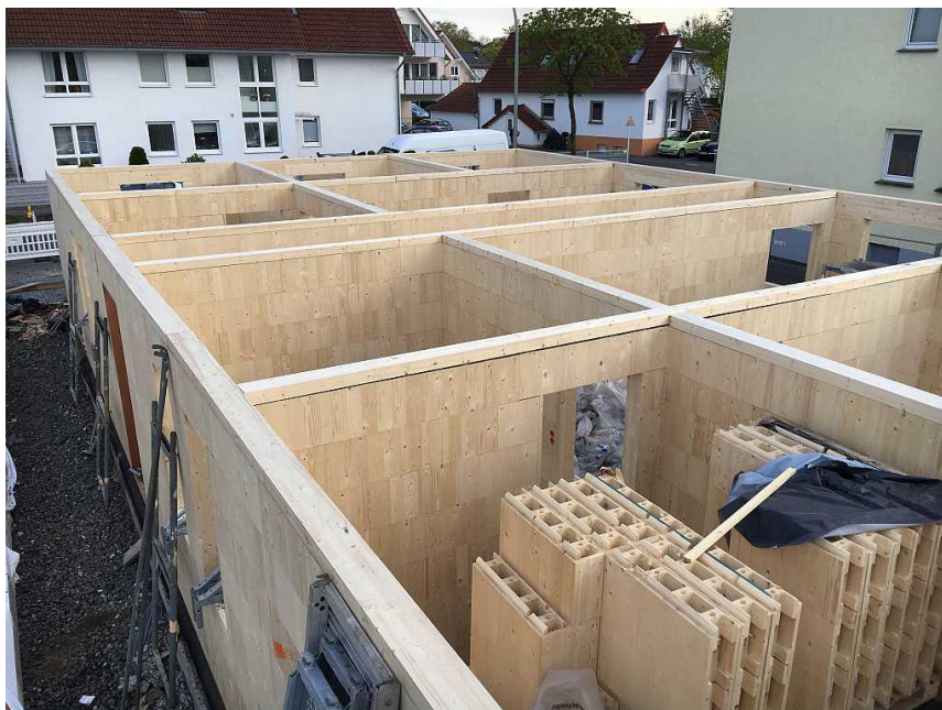
Foto: Heribert Kühlenkamp – Neubau Dietrichstraße in Holzbauweise, Bauherr GMP
