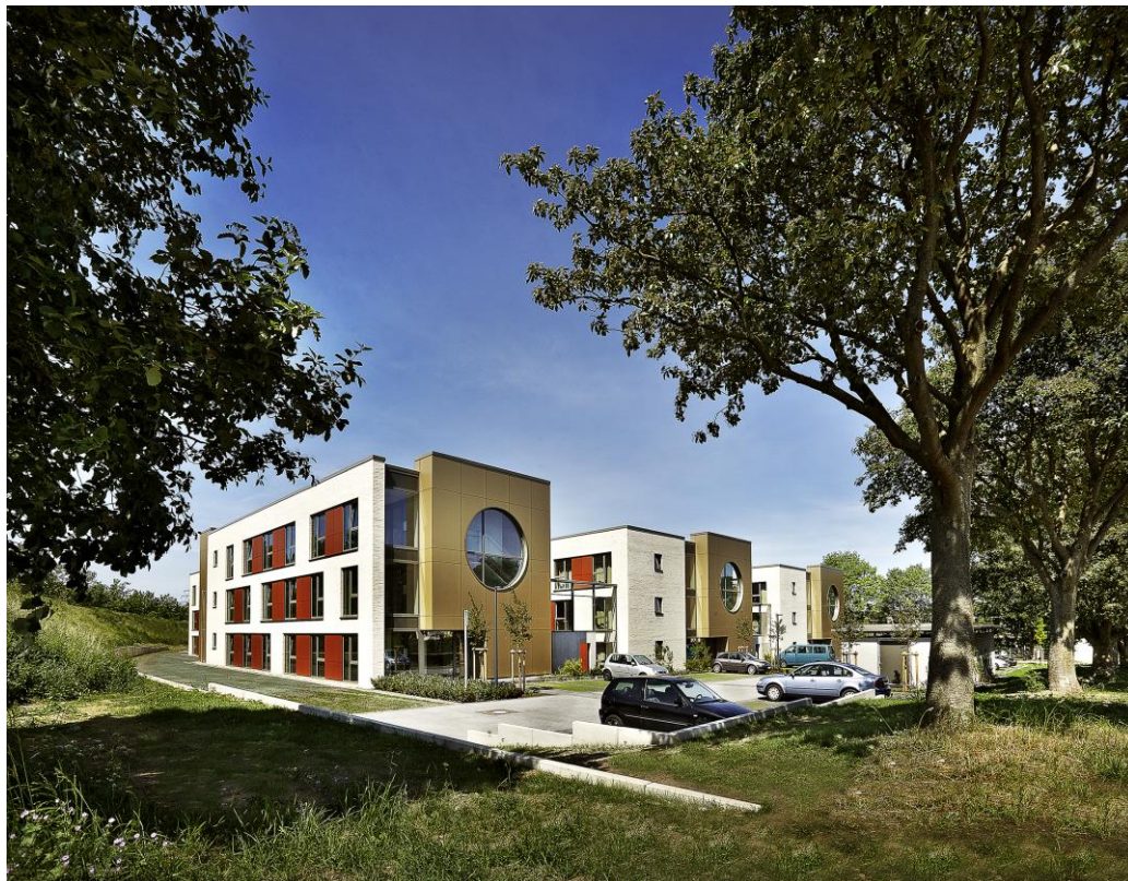
Foto: RSK Architekten, Alois-Fuchs-Weg – Wohnungen für Studierende, Baujahr 2015
