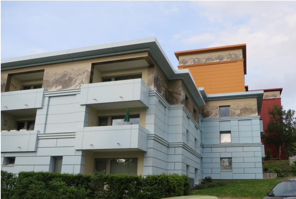
Abbildung 67: Sanierte GWG-Wohnsiedlung Höxterstraße (Bild: IRI)
