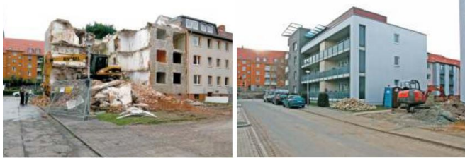
Abbruch/Neubau Pippelsburg, Quelle: Stadt Hildesheim, Beiträge zur Stadtentwicklung 16
